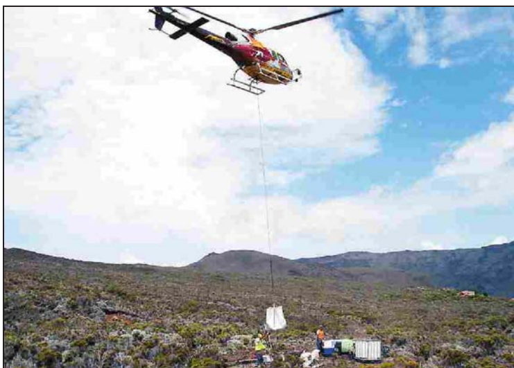
Une bonne partie du matériel nécessaire aux forages a dû être acheminée par hélicoptère.
