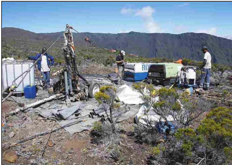
Le chantier de Partage. La réalisation des forages a été confiée à l'entreprise réunionnaise RocS.
